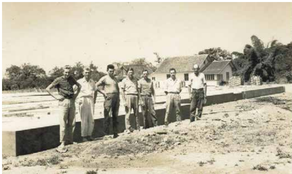
Início da construção do Hospital Bethesda
