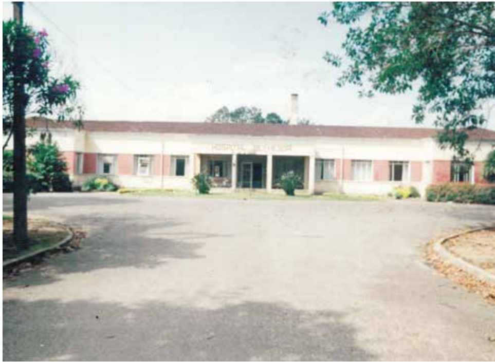
Fachada Hospital Bethesda na década de 1980
